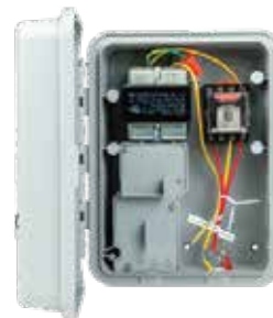
Booster per relè di avvio pompa (PSRB) Altezza: 22 cm Larghezza: 18 cm Profondità: 9,5 cm
